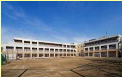
学校を改修して整備した事例
